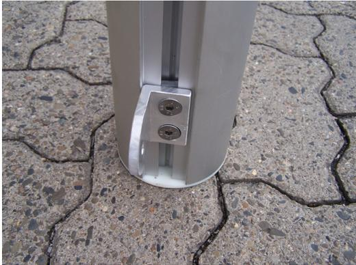
3. Pfosten wieder in die Bodenhülsen einstecken, Scharnierteil ausrichten und Schrauben fest anziehen.
