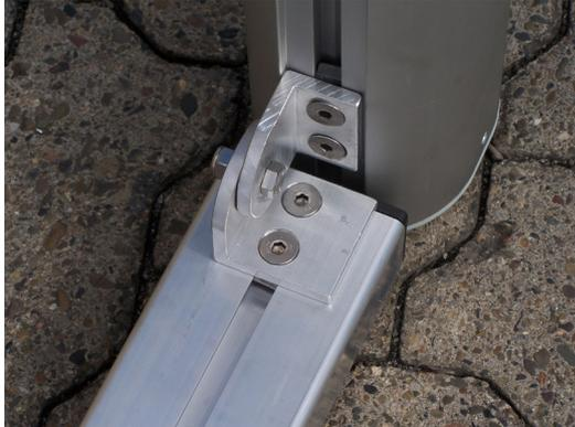
7. Bodenrahmen ausrichten und die unter Pos. 5 eingedrehten Schrauben fest anziehen.
