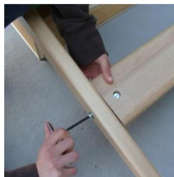
**3/** Befestigen Sie die Querstangen mit den Schrauben (4 Schrauben 8x70 und Ringe) und ziehen sie nun alle Schrauben der Beine fest an.
