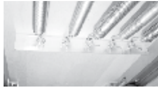
Abb. 3: Federhaken zeigen nach unten
