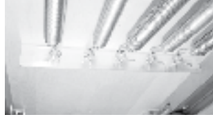
图3: 向下钩住的弹簧
