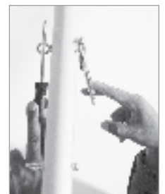
Figure 9: Serrez les boulons avec deux doigts
