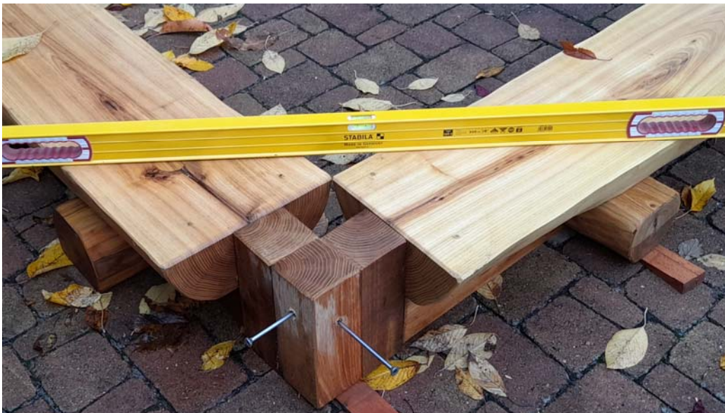
Das Bild zeigt die Montage einer Eckverbindung an einem rechteckigen Sandkasten
