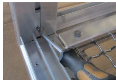
Werkseitig vormontierter Winkel Vorderseite Oberteil mit Laufschiene/Nut für Schiebetür
