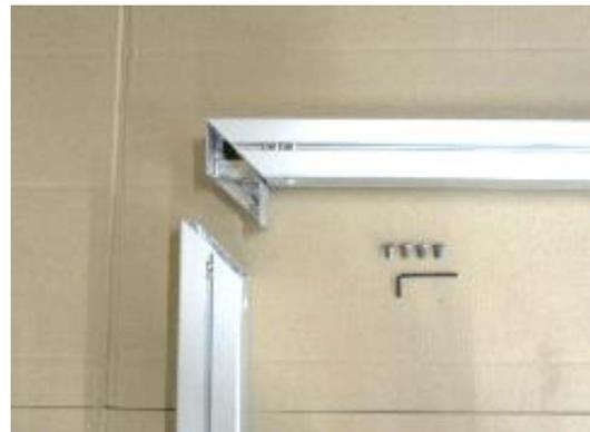
Nun die Pfosten auf die Alu-Guß-Eckverbinder stecken. Darauf achten, dass die Innenecke Latte/Pfosten dicht aneinander liegt, aber dabei die Außenecke wie abgebildet, etwas offen lassen (siehe Foto unten links und Skizze unten rechts). Jetzt 2 Stck. Sicherungs-Senkschrauben M 8 x 20mm, DIN 7991 an jeder Innenecke lose einschrauben (siehe Foto unten). Danach das Tor aufrichten (siehe Foto unten Mitte).
