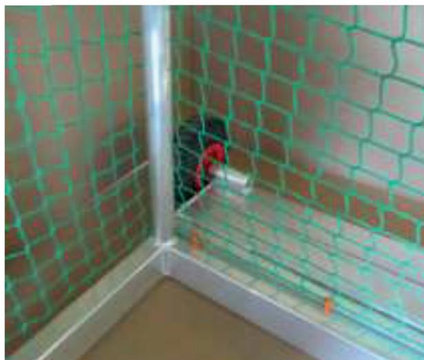
Die Demontage der Netze erfolgt ebenfalls durch eine 90°-Drehung der Netzhalter. Hierzu ggf. ebenfalls einen dünnen Schraubenzieher verwenden.
