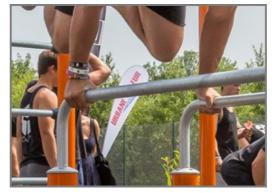
Die Stangen, die als Griffe für Übungen gedacht sind, bestehen aus feuerverzinktem Stahl mit einem Durchmesser von 38 mm. Ein geeigneter Durchmesser um die Handgelenke bei Dips oder Handständen zu unterstützen.
